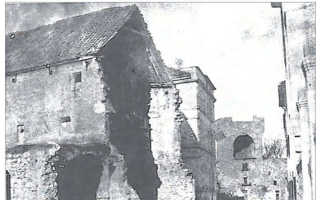
Démolition du chevet de l'église : travaux de percée de la rue Saint Thomas d'Aquin (Médiathèque d'Arles)
